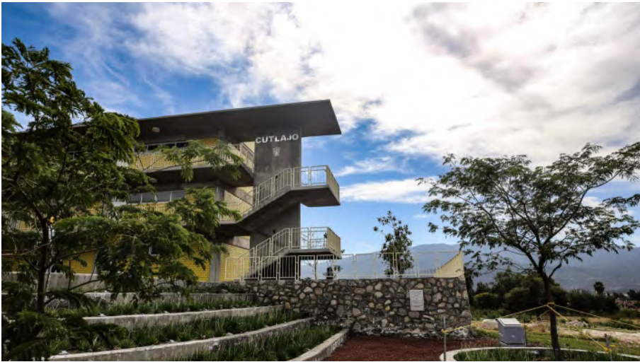
Edificio de aulas en el CUTLAJOMULCO
