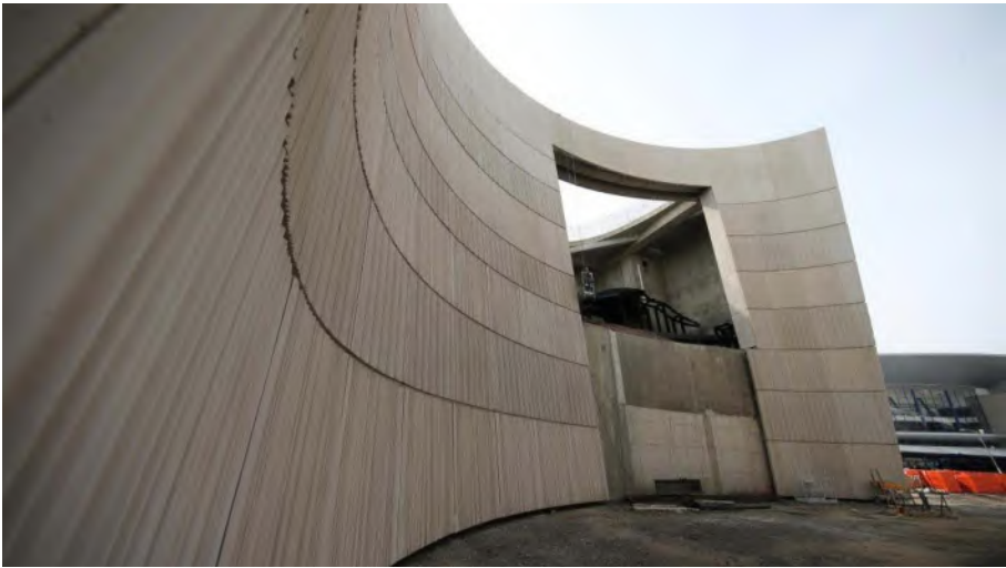
Avance de la obra del Museo de Ciencias Ambientales
